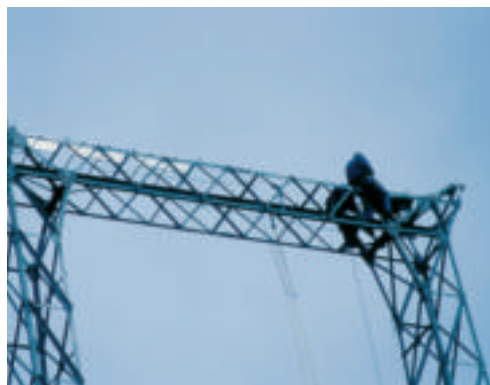
Instalación de disuasores de nidificación
