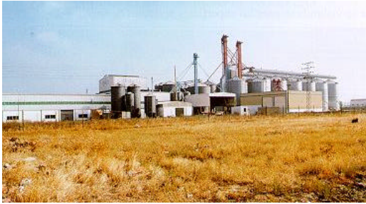
Instalaciones arroceras, Don Benito
