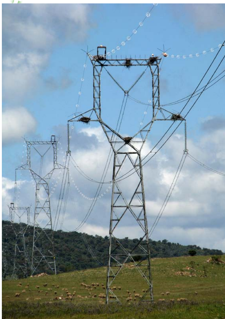
Apoyo de línea de transporte con medidas salvapájaros instaladas
